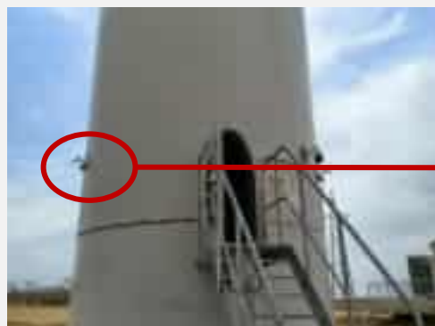
塔筒外放置的声音传感器
